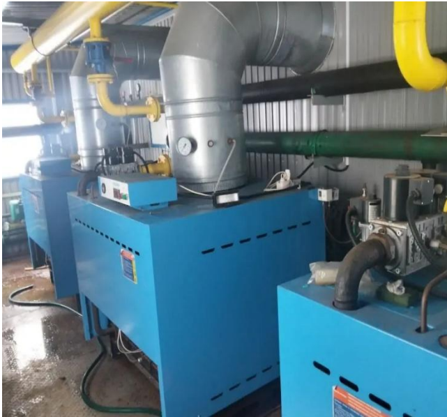
Модульная газовая котельная
