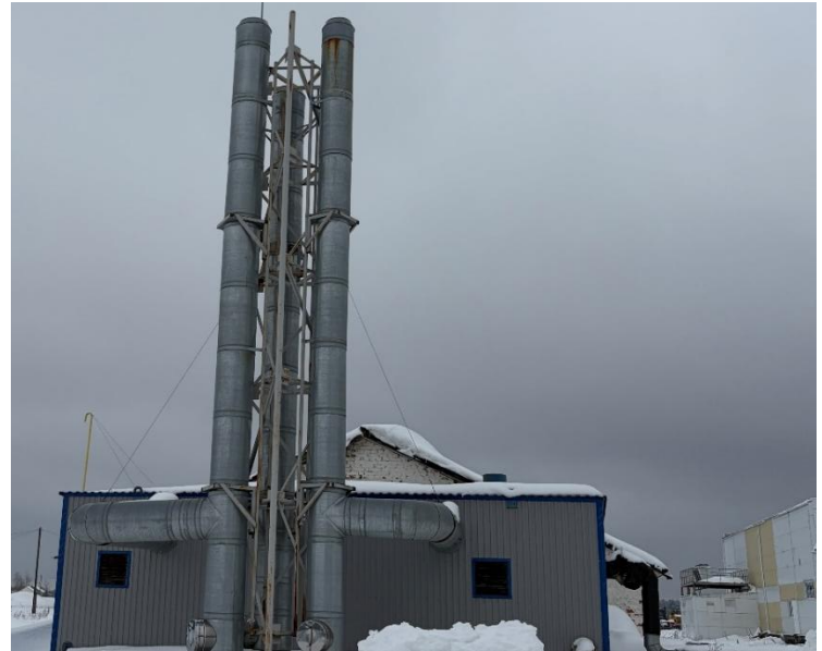
Модульная газовая котельная
